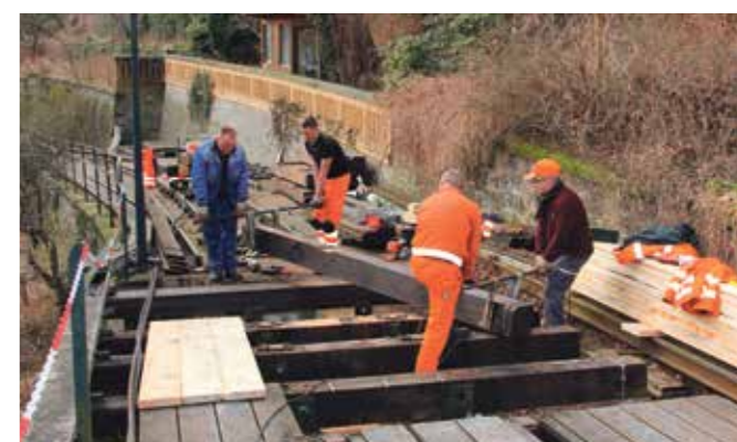
Insgesamt 17 Holzschwellen mussten auf der Strecke gewechselt werden. Das war nichts für halbe Kerle.
