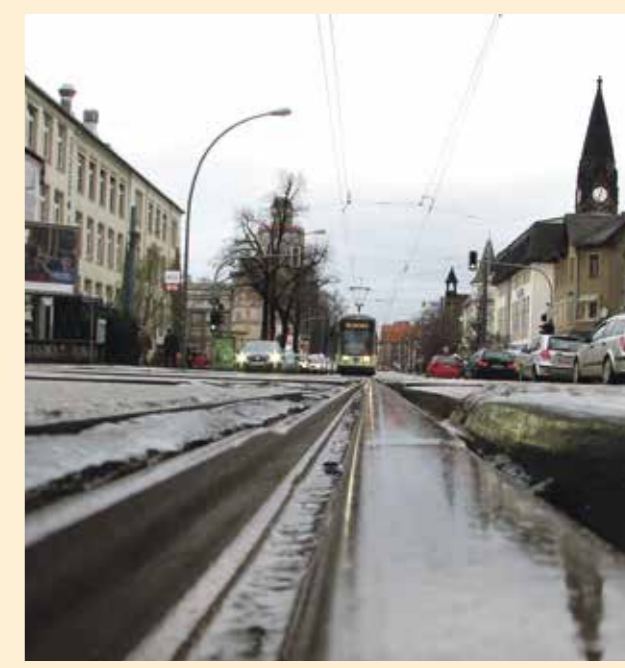
Nicht nur im Gleisbereich signalisiert die Schandauer Straße dringenden Sanierungsbedarf. Auch der Straßenbelag und die Medien im Untergrund sind völlig verschlissen.
