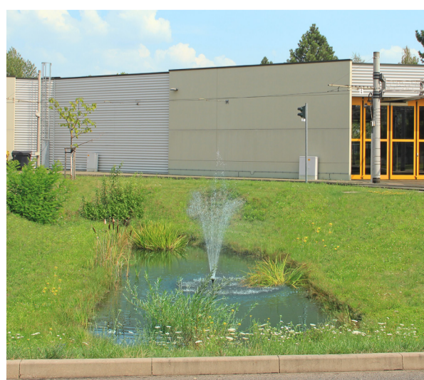
In Rigolen aufgefangenes Regenwasser wird im Straßenbahnhof Reick gleich für die Wagenwäsche verwendet und wieder aufbereitet. Dafür kann auf Frischwassereinsatz verzichtet werden.
