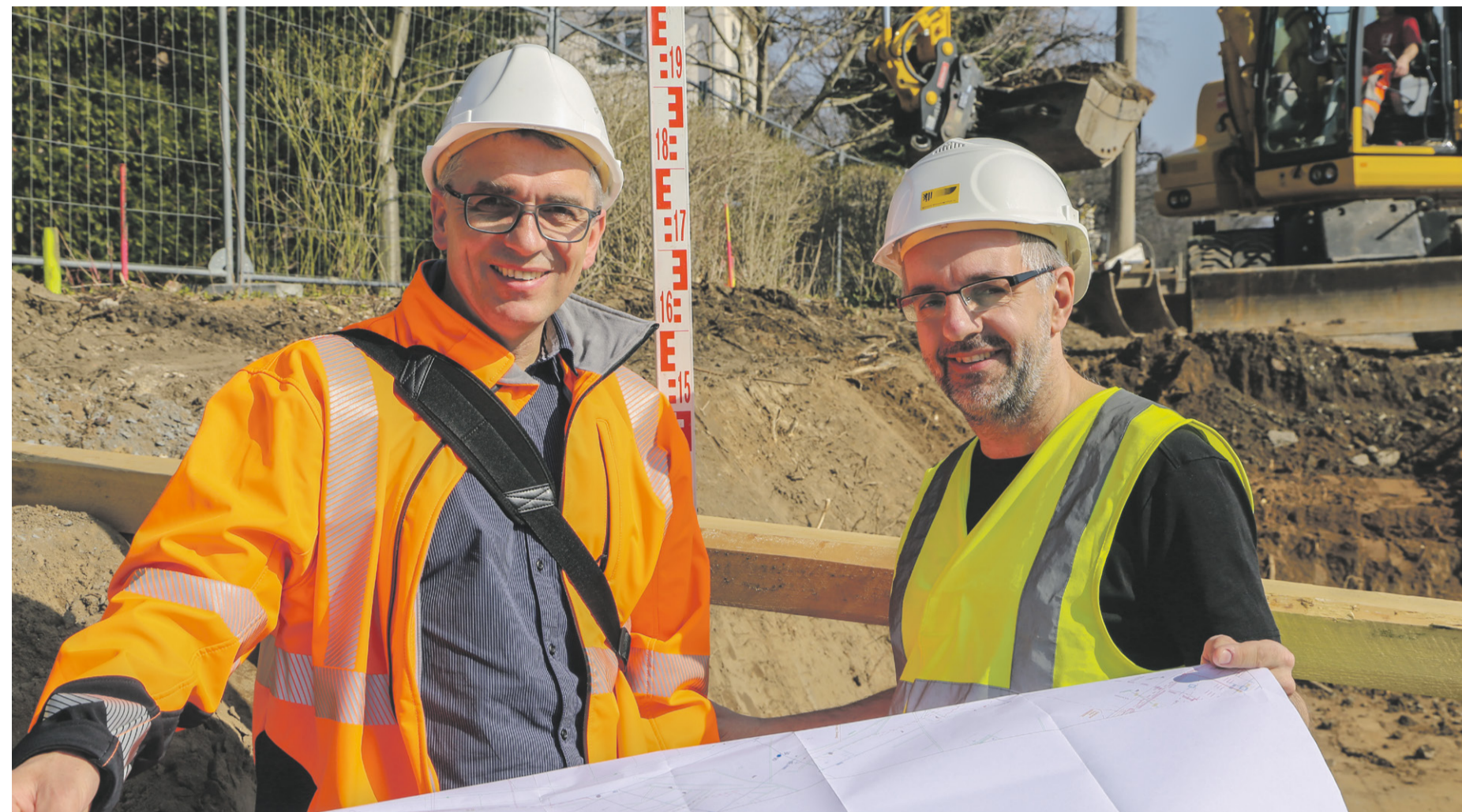
Der Aufbau von Straßenbahnschienen und einer neuen Straßendecke bildet für die DVB-Bauingenieure Torsten Zingel (links) und Steffen Lehmann oft nur den Abschluss einer typischen Gleisbaustelle. Bis zu 90 Prozent aller Arbeiten finden zunächst unter der Erdoberfläche statt.
