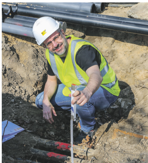
Trotz akribischer Vorbereitung finden die Bauleute immer etwas Überraschendes. Auf der Meißner Straße in Radebeul begutachtet Steffen Lohmann eine alte Gasleitung, die in keinen Plänen eingezeichnet war.
