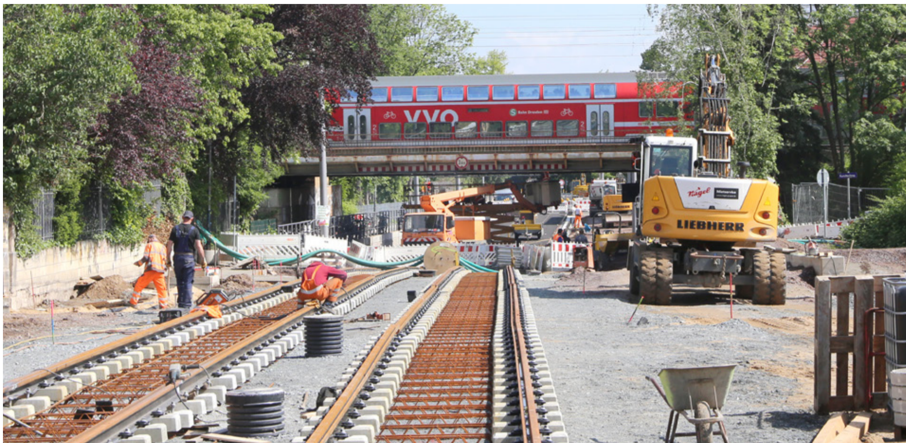
Endspurt für die Bauarbeiten am Bahnhof Strehlen. Auch der neue Umsteigepunkt zur S-Bahn hat längst Konturen angenommen. Die Stadtbahntrasse über die Oskarstraße soll am 6. Juli 2019 eröffnet werden. Bereits am 5. Juli bieten die Verkehrsbetriebe kostenlose Sonderfahrten auf der Neubaustrecke an.
