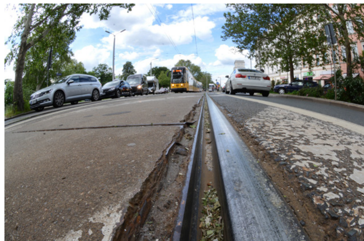
Die verschlissenen Schienen auf der Bautzner Straße dürfen von den Straßenbahnen nur noch mit reduzierter Geschwindigkeit befahren werden. Deshalb bauen Stadt und Verkehrsbetriebe in den Sommerferien neue Gleise ein. Parallel entstehen in jeder Richtung Radwege für mehr Sicherheit der Pedalritter. Foto: D. Flechtner
