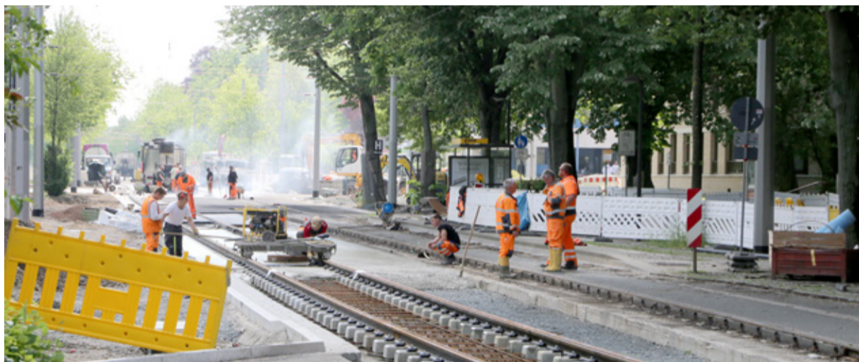
Die Haltestelle „Querallee“ wird nun auch in Richtung Innenstadt barrierefrei zugänglich. Das erleichtert vor allem den Besuchern des Großen Gartens das Ein- oder Aussteigen in Bus und Bahn.
