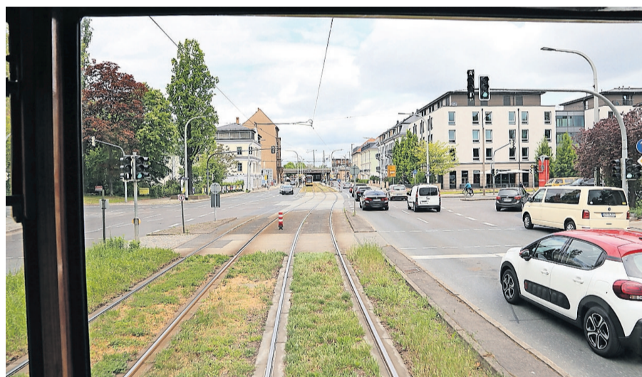
Mit der neuen Technik bekommen Straßenbahnen nur dann bevorzugt grün, wenn es wirklich gebraucht wird. Der Palaisplatz muss allerdings warten. Zuerst werden die Ampeln am Straßburger Platz, am Bahnhof Mitte und auf dem Stadtring umgerüstet.
