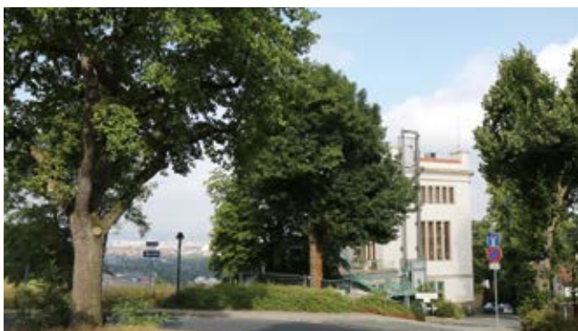
Blick zur oberen Station der Schwebelbahn
