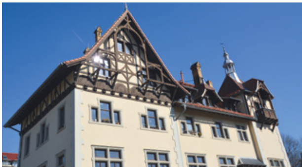
ehemaliges Gasthofgebäude Wilder Mann (1)
