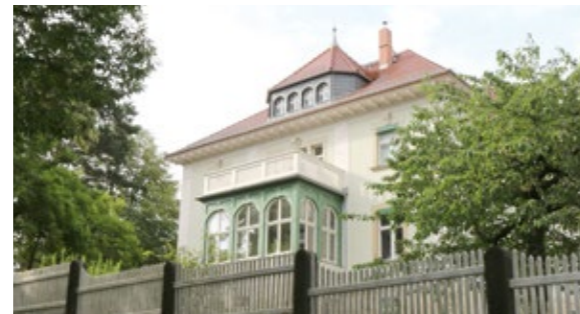
alte Villa in der Sieksstraße (3)
