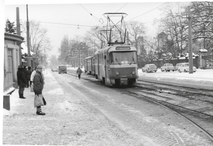
Abb. oben: Verlegen von Betongleisjochen in der Wehlener Straße in den 1980er Jahren
