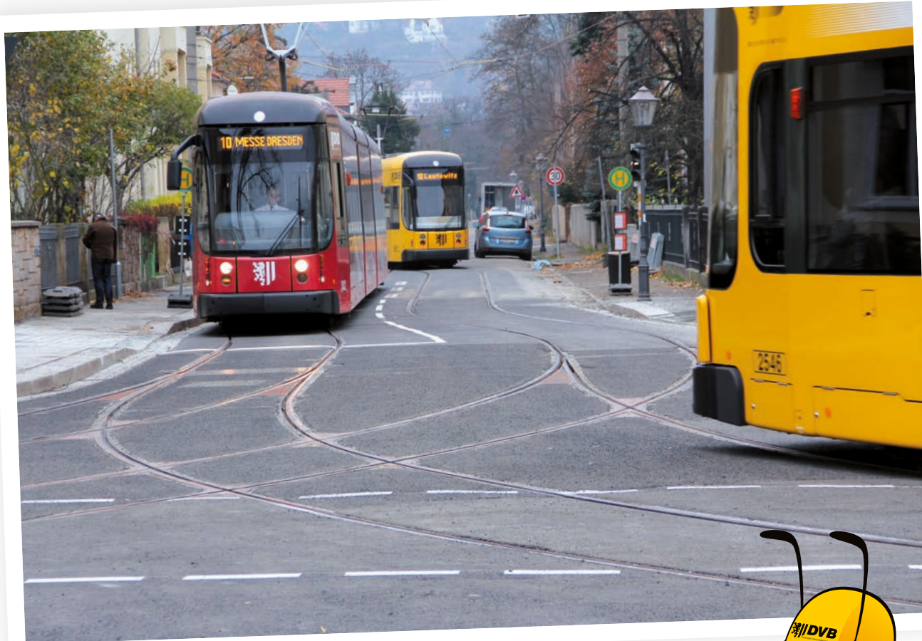
Über das Gleisprovisorium kurvt Wagen 2546 von der Wehlener in die Ludwig-Hartmann-Straße.
