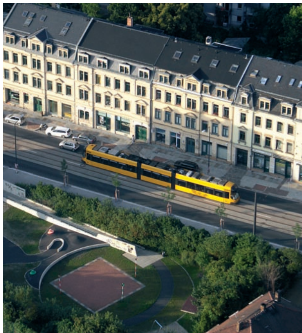
Seit Mitte letzten Jahres ist die Leipziger Straße komplett saniert.
