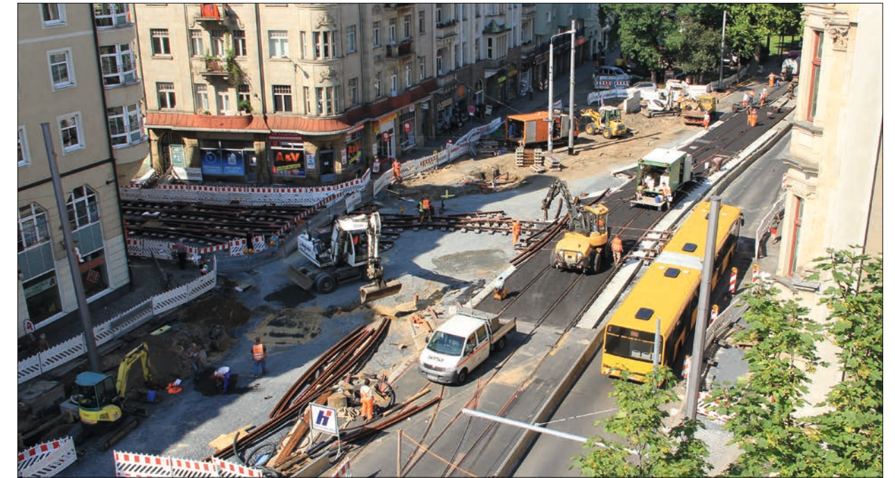
Die Kreuzung Bautzner/Rothenburger/Hoyerswerdaer Straße in der Äußeren Neustadt wurde im Sommer 2013 komplett erneuert.
