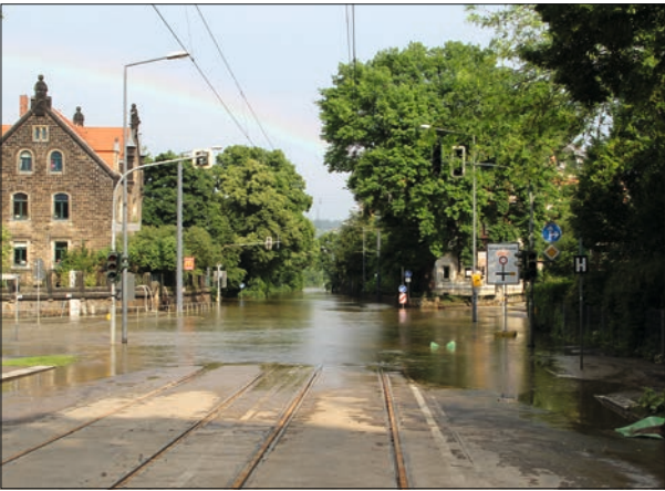
Im Juni 2013 hat die Elbe Teile der Wehlener Straße überflutet.
