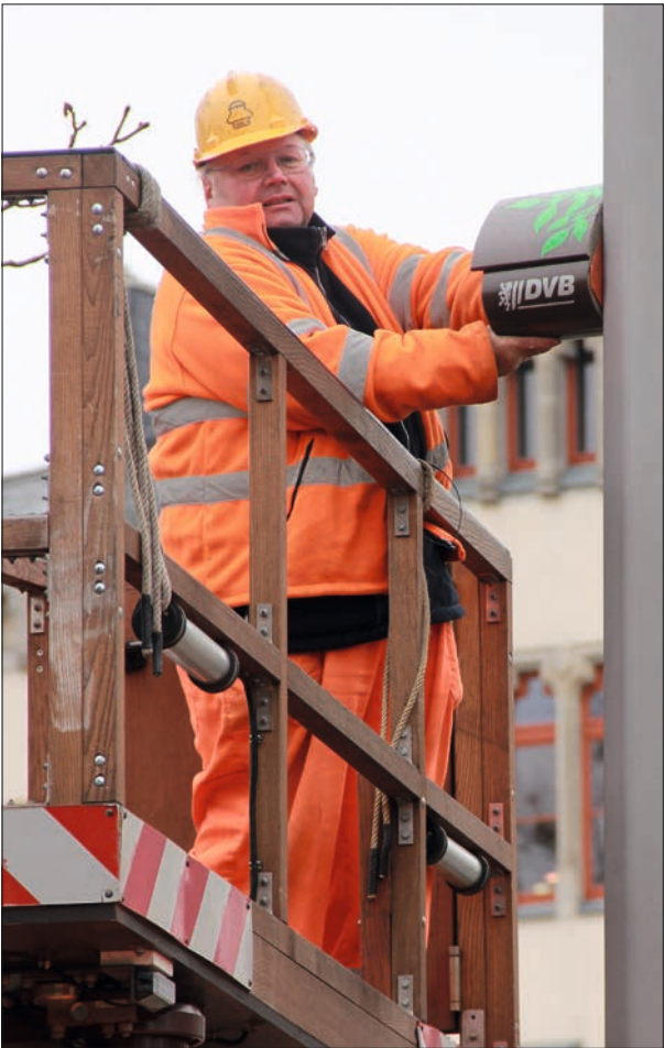
Eine neue Aufgabe für unsere Fahrleitungsmonteure – das Anbringen von Meisenkästen an der Bautzner Straße.
