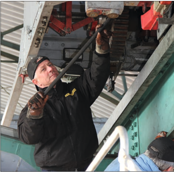
Einen wesentlichen Teil der Arbeiten bei der Hauptuntersuchung der Schwebebahn im letzten Jahr haben die Mitarbeiter der Gruppe Bergbahnen selbst ausgeführt.
